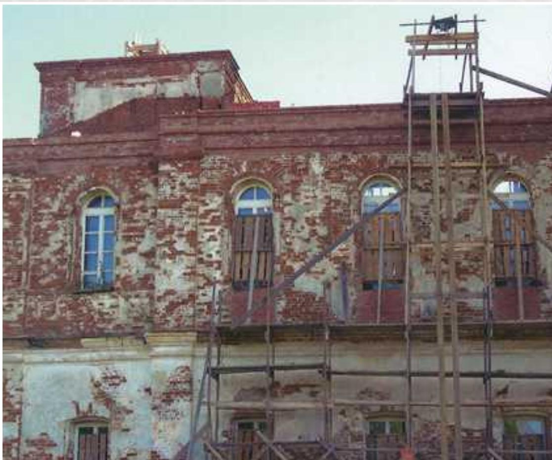
Работы на Успенском Соборе по выемке разрушенного кирпича и новой кладке верхних рядов стен храма
